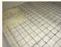
床は合板を貼り、ワイヤー メッシュを敷いて温水用パイ プを固定後にモルタルを流し ます
