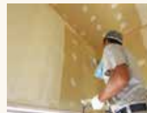
壁・天井は石膏ボードを貼り、 仕上げとしてリバースコート を塗ります
