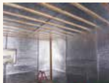
床・壁・天井に遮熱シートを 貼ります
