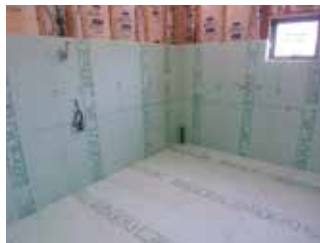
床・壁・天井に断熱材を入れます(壁は二重)
