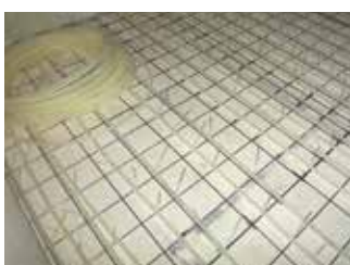
床は合板を貼り、ワイヤーマッシュを敷いて 温水用パイプを固定後にモルタルを流します
