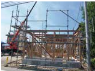
住宅同様に柱・梁等を組んでいきます
