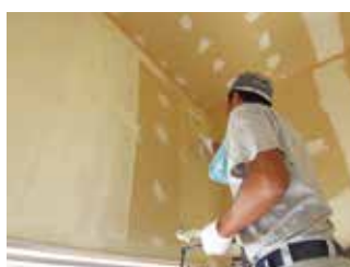
壁・天井は石膏ボードを貼り、仕上げとして リバースコート(珪藻土仕上げ材)を塗ります
