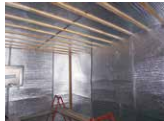
床・壁・天井に遮熱シートを貼ります
